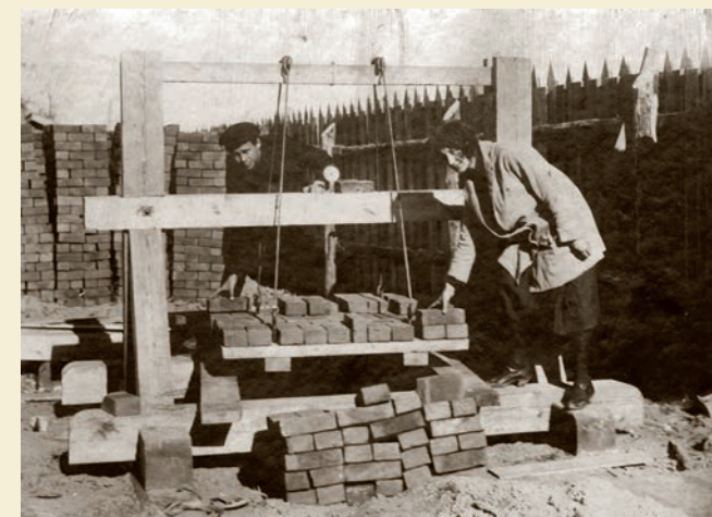
Первые кирпичи для строительства бумкомбината.
