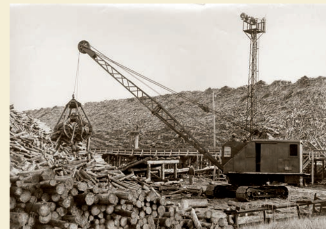
Механическая разборка древесных куч. Подача древесины в производство. Бумкомбинат, 1962 г.
