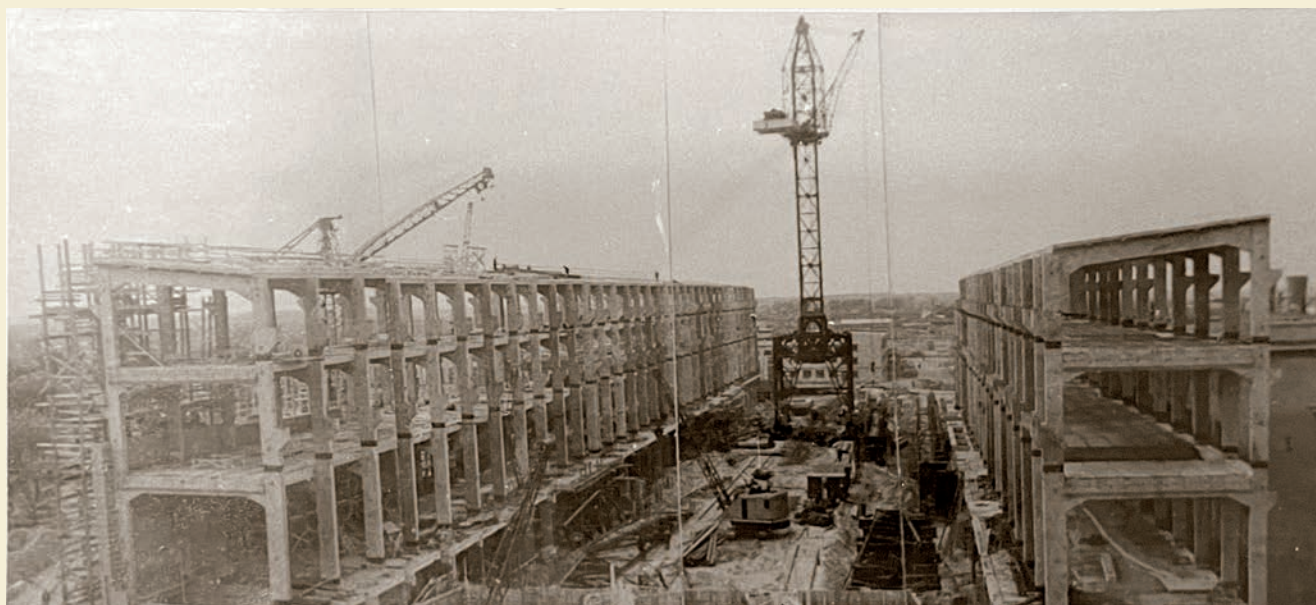
Полным ходом идет строительство здания шестой и седьмой скоростных автоматизированных бумагоделательных машин.
