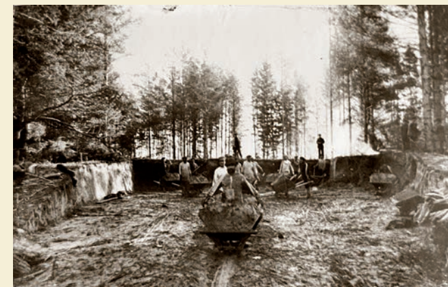
Темпы строительных работ впечатляли, даже несмотря на то, что, в основном, применялся ручной труд.
